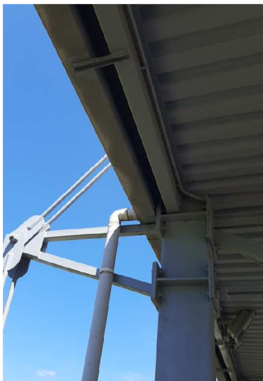
Foto 7 Dettaglio gronda e pluviale tettoia
