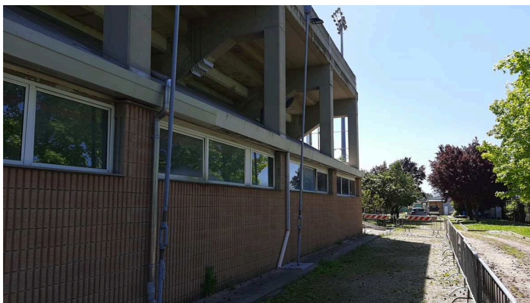
Foto 6 Dettaglio Canale di gronda piano terra
