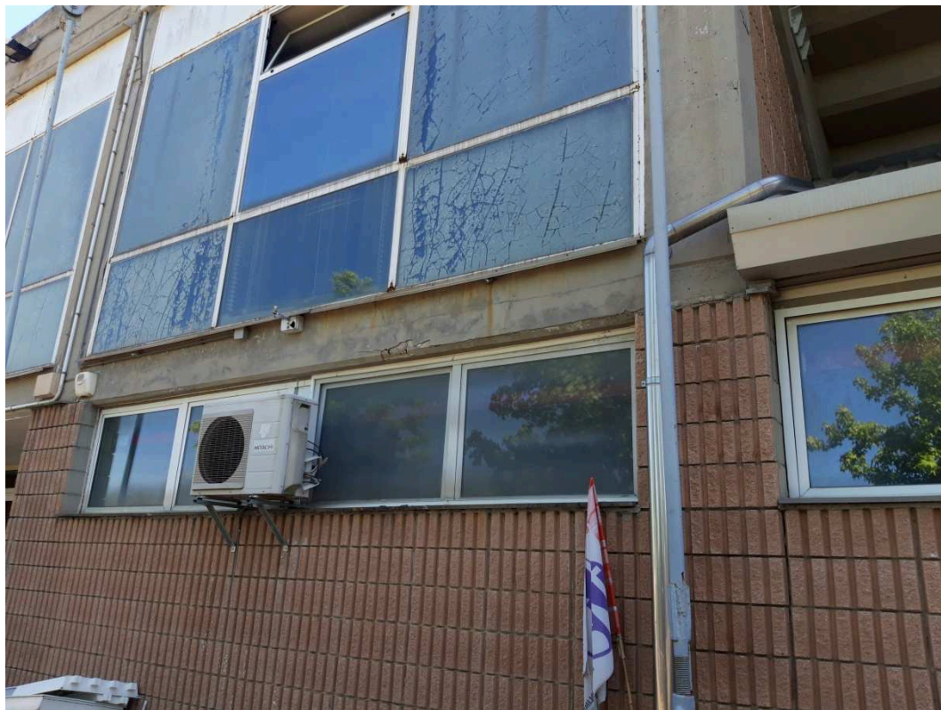
Foto 5 Dettaglio calcestruzzo oggetto di ripristino corticale
