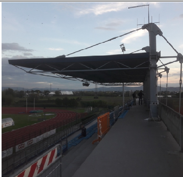
Vista Tettoia e parapetto da tribune
