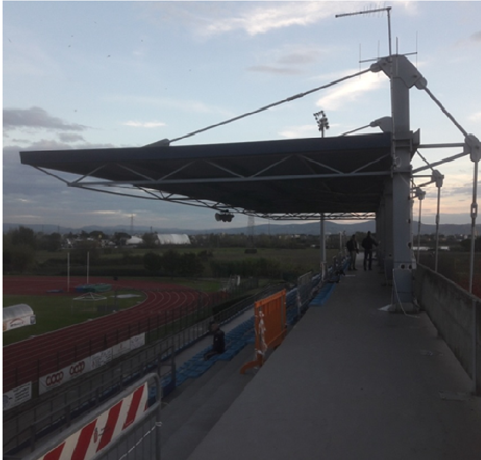
foto 1 – Tettoia e parapetto da tribune_ oggetto interventi Lotto 1-2 (vista da tribune)
