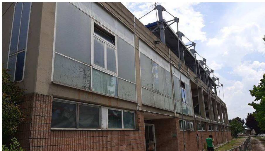
Vista tettoia parapetto e specchiature tamponamenti in infissi (prospetto tergale)
