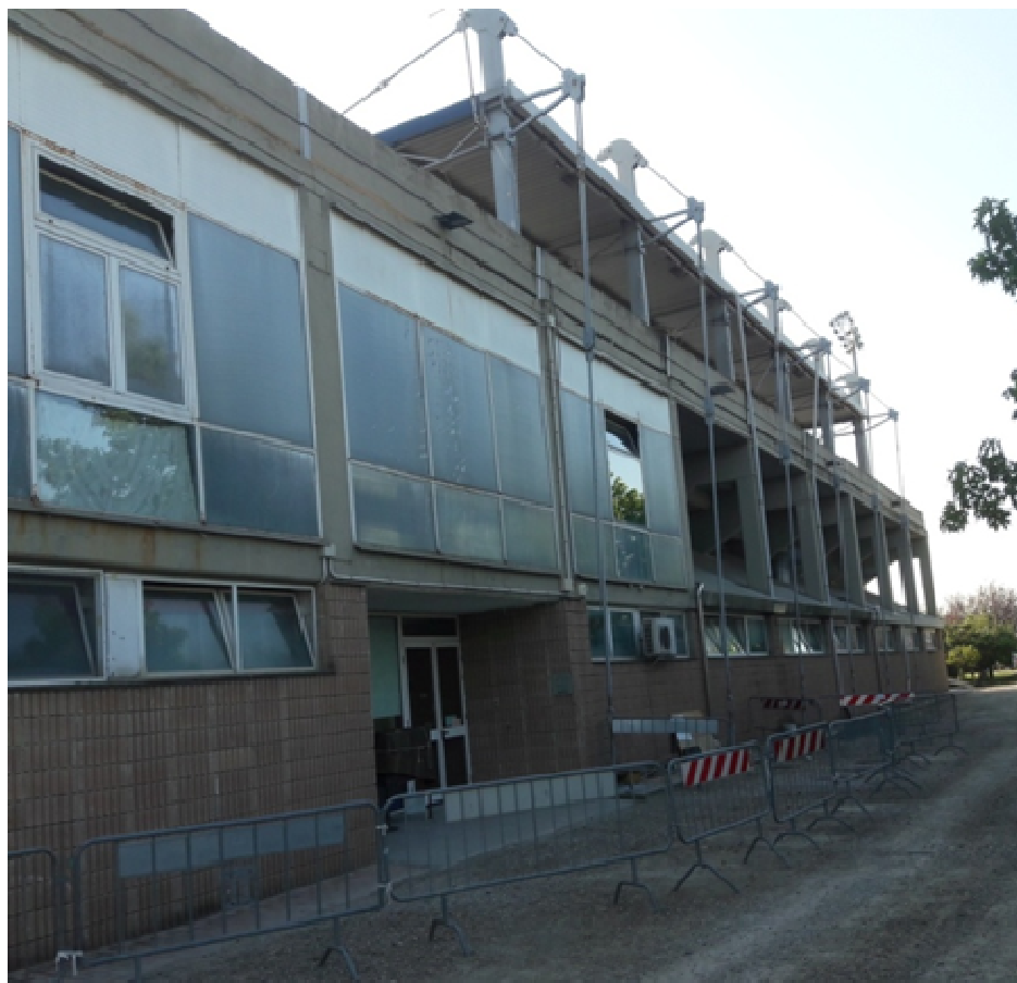
foto 2: Tettoia parapetto e tamponamenti oggetto interventi Lotto 1-2-3 (vista da tergo)
