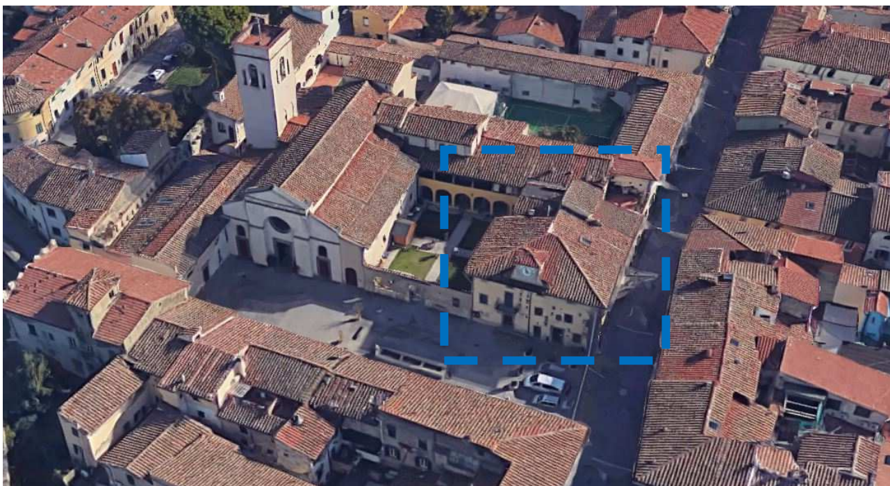
Viste panoramiche (Vista NORD) – Google Maps
