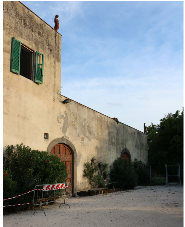
Foto di Villa Rucellai (muro della corte della Parte Quattrocentesca)
