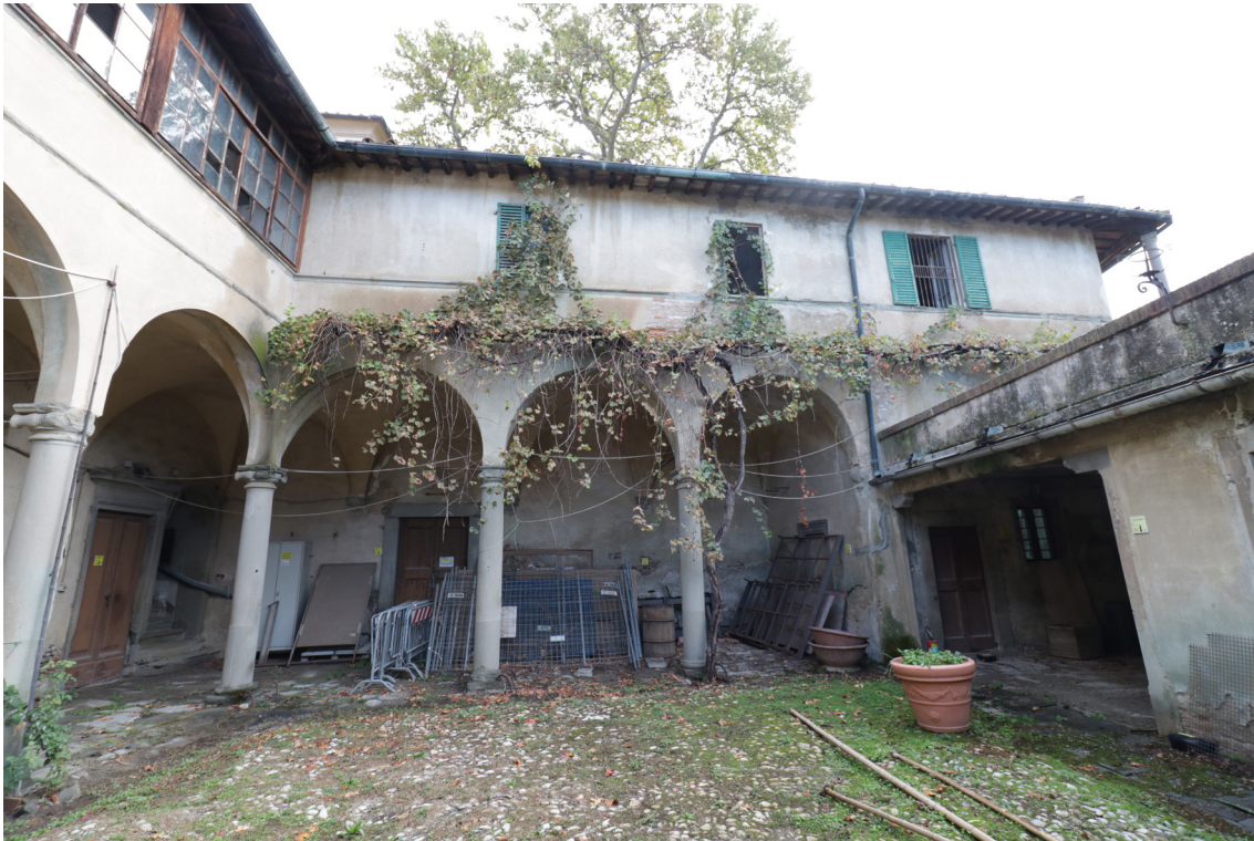
Foto della corte (lato est)
