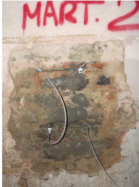
Esecuzione di prove a martinetto piatto singolo
