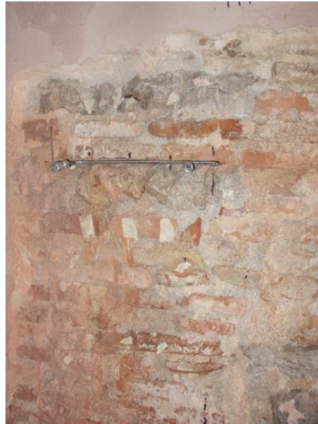
Esecuzione di prove a martinetto piatto singolo
