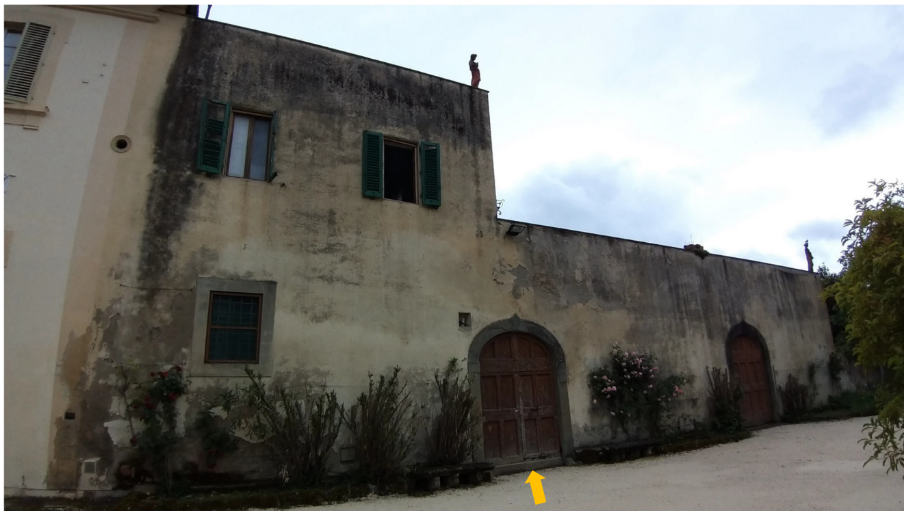
Accesso all'area di cantiere
