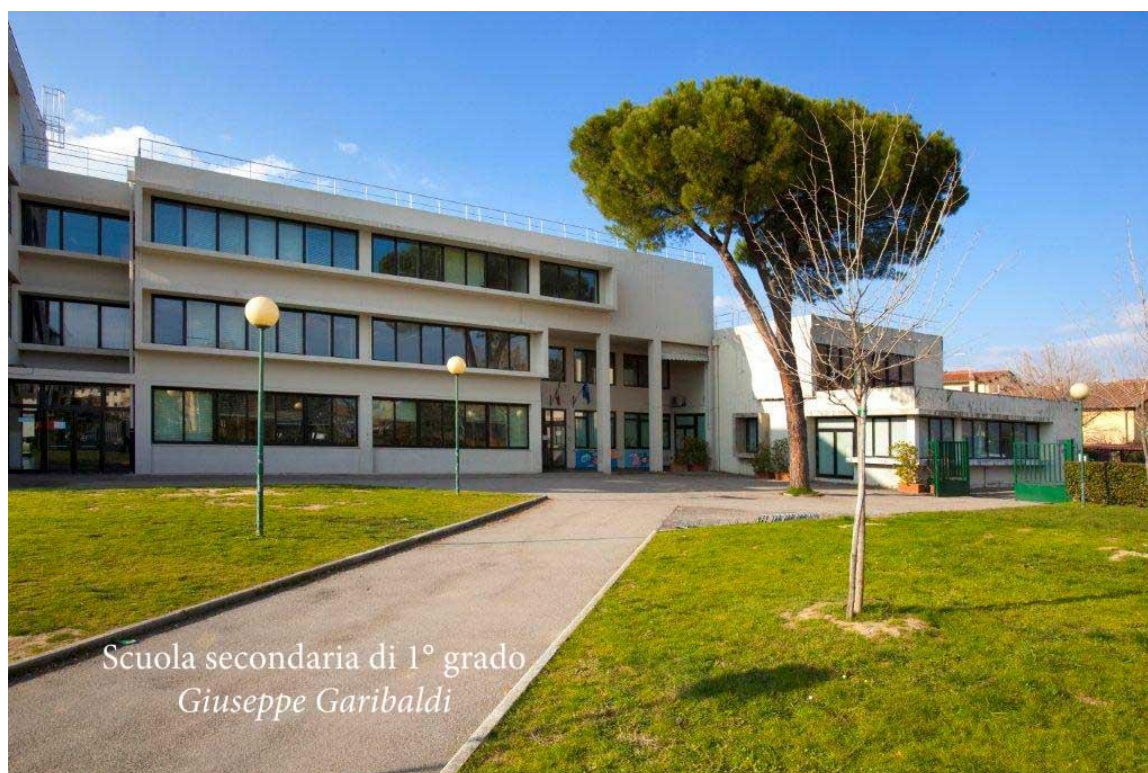
Figura 1 - FACCIATA PRINCIPALE SU VIA GARCIA LORCA
