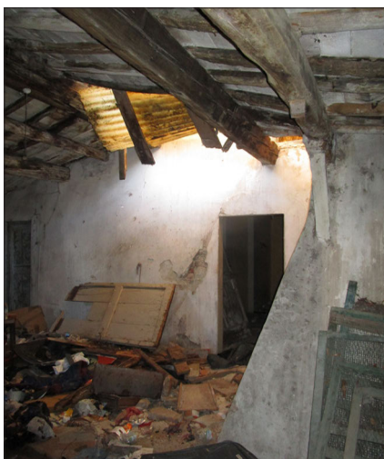
Porzioni di copertura crollate all'interno degli ambienti minori
