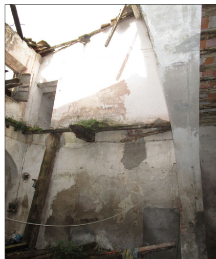
Porzioni di copertura crollate all'interno degli ambienti minori
