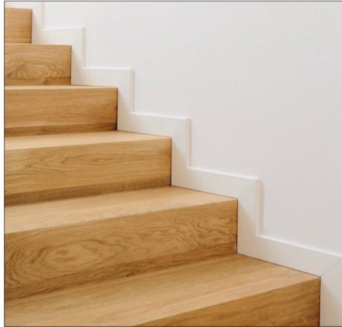
Immagine esemplificativa della finitura dei gradini della scala, realizzati in legno di rovere con raccordo tra alzata e pedata con giunzione a 45° e spigoli arrotondati
