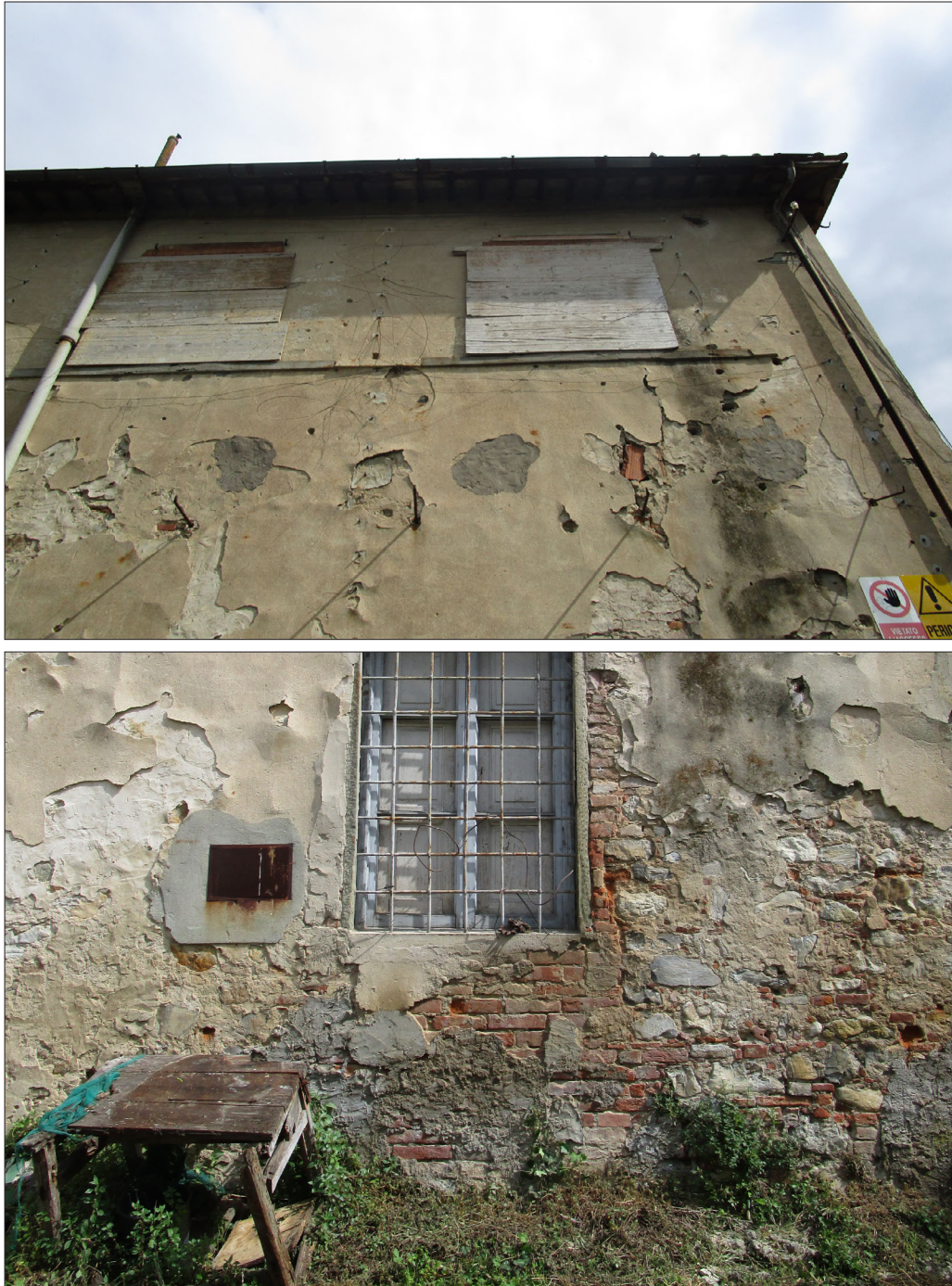
Documentazione fotografica relativa allo stato di conservazione degli intonaci
