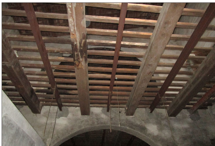
La foto mostra il solaio dell'ambiente principale, con le travi lignee affiancate da putrelle in acciaio
