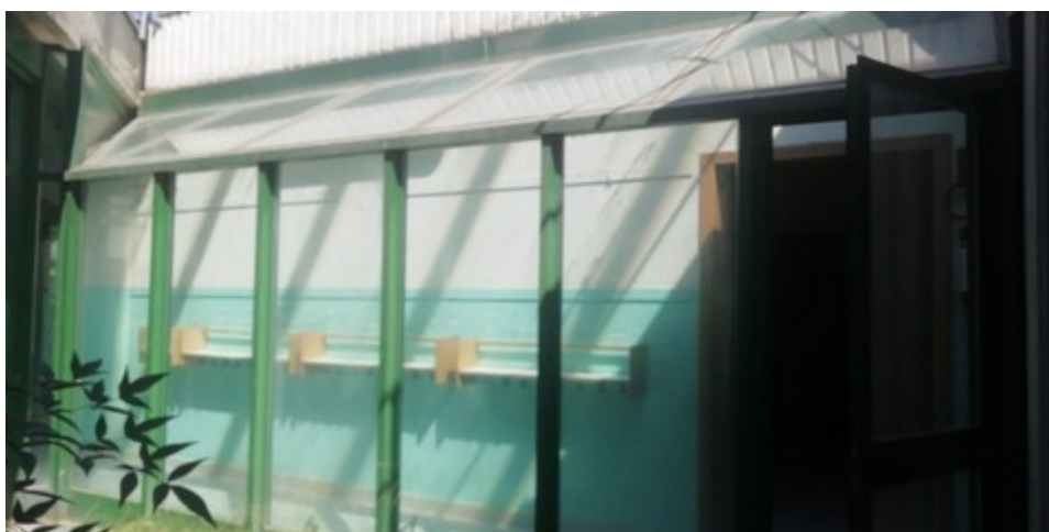
Foto n.2 – vista dalla corte interna
