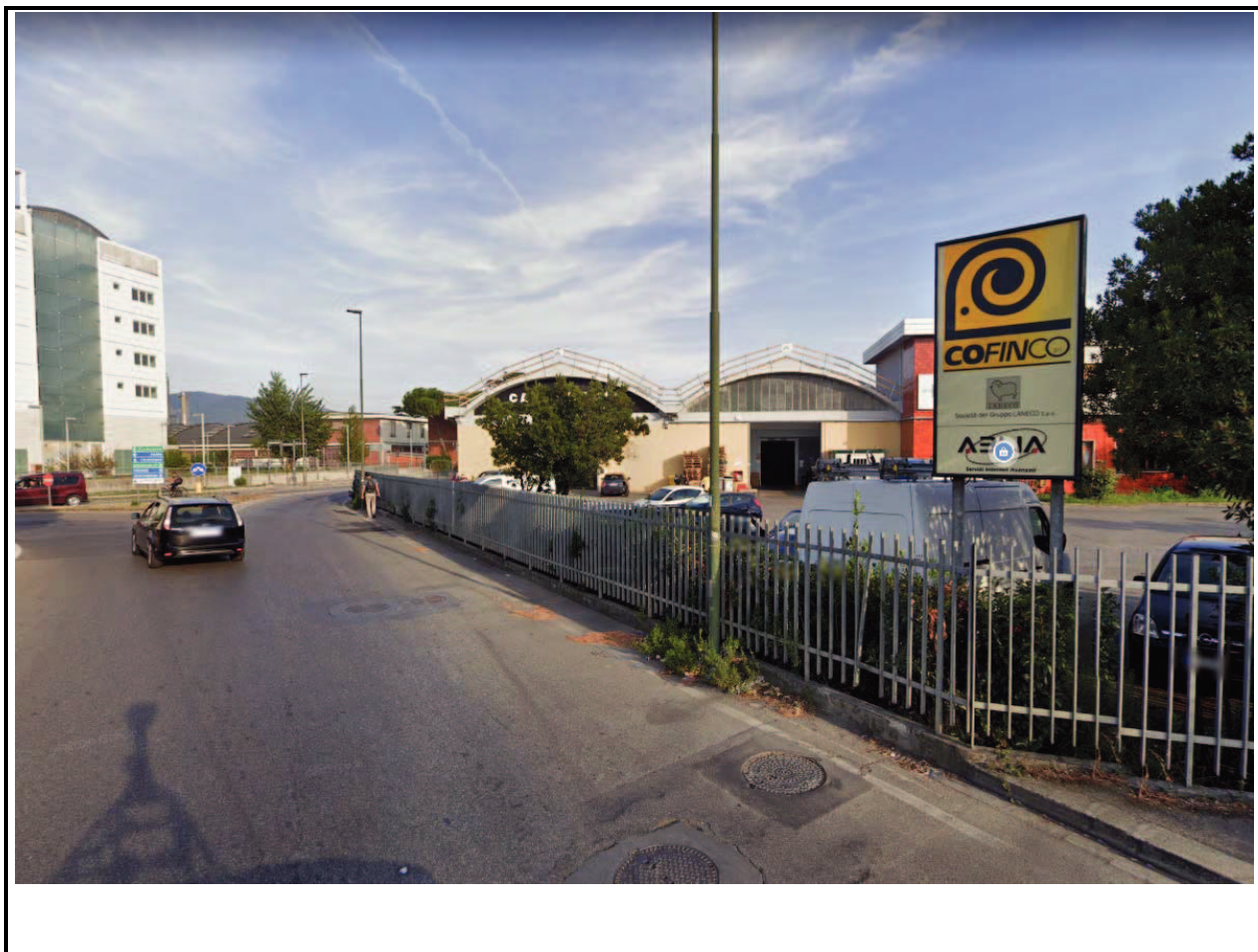
Foto n. 7 Recinzione perimetrale del complesso
