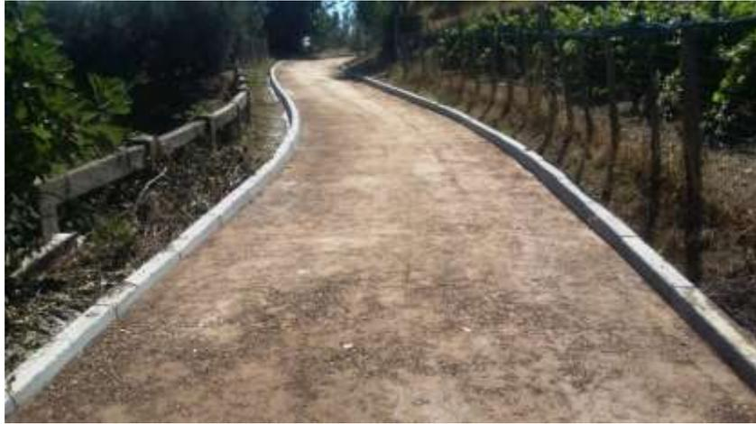
Una terza tipologia di pavimentazione, **Pavimentazione Tipo 3**, è stata utilizzata per il tratto di ciclabile posta sul sedime della vecchia via di Fornello, per tale tratto è prevista una fresatura della pavimentazione esistente e la successiva stesa di uno strato di base in conglomerato bituminoso alto 5 cm e uno di usura alto 3 cm realizzato, come per gli altri tratti, in resina trasparente tipo “Sacatrasparent” che fa da legante e una miscela di inerti naturali.
