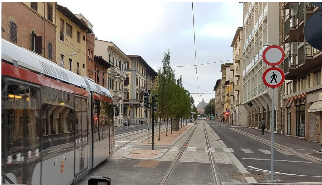
Figura 5 - Sede tranviaria riservata con cordolo laterale
