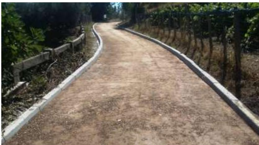
Una terza tipologia di pavimentazione, **Pavimentazione Tipo 3**, è stata utilizzata per il tratto di ciclabile posta sul sedime della vecchia via di Fornello, per tale tratto è prevista una fresatura della pavimentazione esistente e la successiva stesa di uno strato di base in conglomerato bituminoso alto 5 cm e uno di usura alto 3 cm realizzato, come per gli altri tratti, in resina trasparente tipo “Sacatrasparent” che fa da legante e una miscela di inerti naturali.
